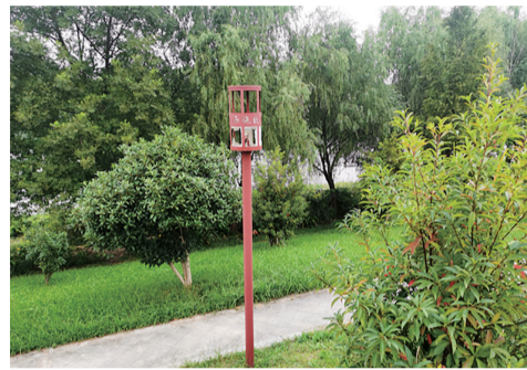
浦阳江游步道路灯的灯罩破损。
