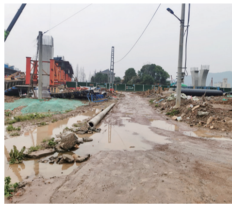
暨阳街道孙家村寺后王自然村出村道路被淹。
